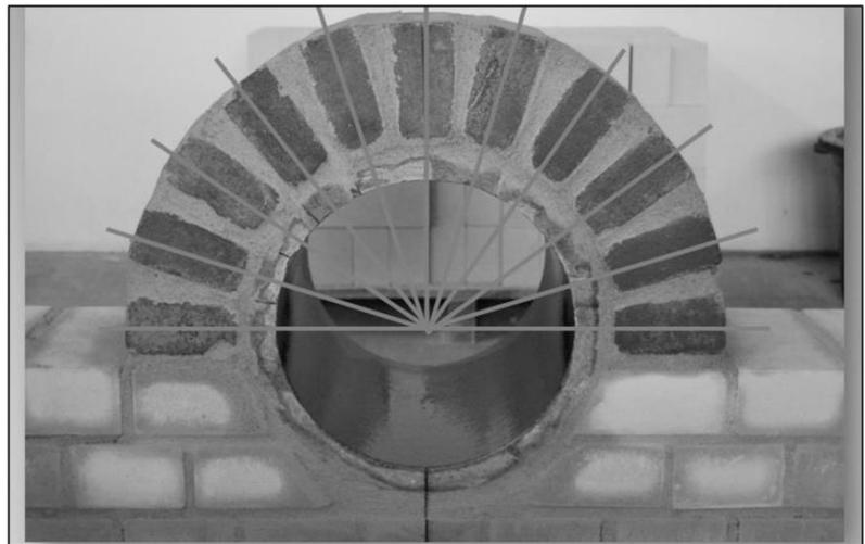
Entlastungsbögen aus Kanalkeilklinker verstärken die Rohrwandungen im Einbaugelenkstück. Bild Koch
