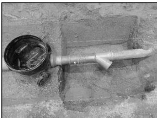
Bild „Nachträglicher Einbau eines Abzweigs“
